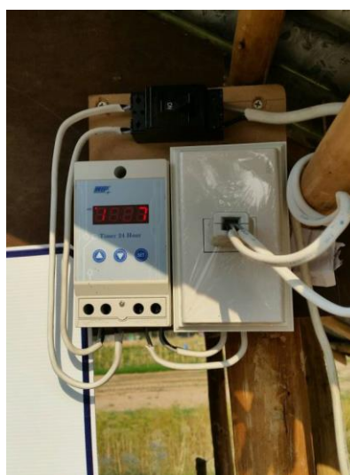
นาฬิกาอัตโนมัติสำหรับเปิด-ปิดพัดลม
