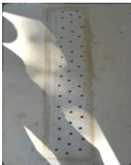
เจาะแผ่นยิปซัมด้านล่างเป็นตะแกรง ขนาด 20x100 เซนติเมตร
